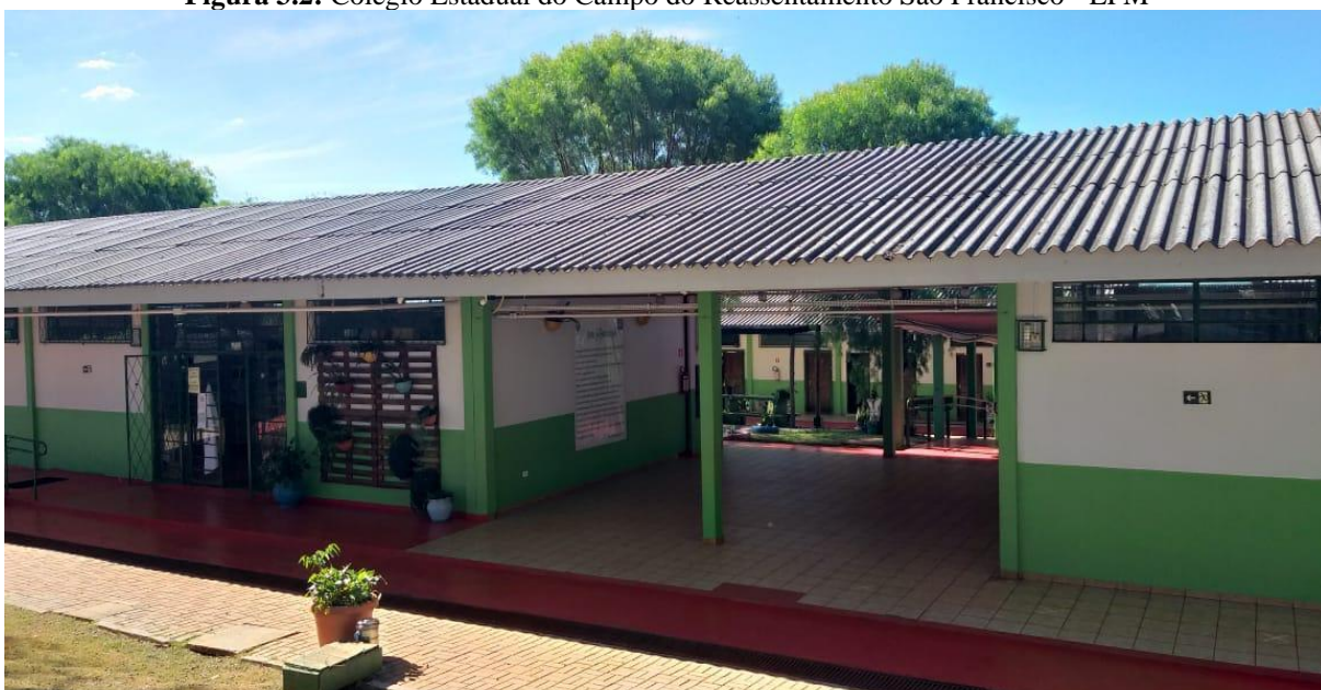
Figura 3.2: Colégio Estadual do Campo do Reassentamento São Francisco - EFM
